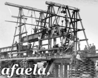
Montaje del puente sobre el río Salado, en el ramal de Manuel Gálvez (Nelson) a San Cristóbal. Agosto de 1891. (A.F.F.C.S.F.). Abajo: Momento en el que se coloca un tramo del puente (A.F.F.C.S.F.).
