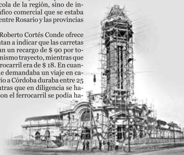
Construcción de la Estación de Rosario del F. C. Santa Fe, actualmente terminal de ómnibus (A.F.F.C.S.F.).
